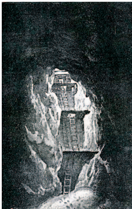
Prikaz napredovanja rudarskom tehnikom u jami Abisso di Trebiciano (Bertarelli, 1926)
