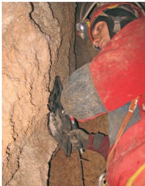
Stavljanje gumene ploče preko mjesta koje će se razbiti eksplozivom (foto: Damir Slatinac)
