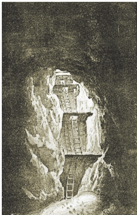
Prikaz napredovanja u dubinu rudarskom tehnikom u jamu Grotta di Trebiciano gradeći drvene platforme jednu ispod druge (preslika iz: Bertarelli & Boegan, 1926)
