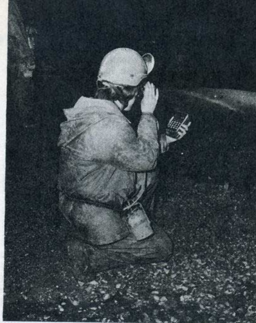
Ing. Garašić mjeri optičkim klinometrom i džepnim računarom pri topografskom snimanju kaverne u tunelu »Učka« 7. 1. 1978.
