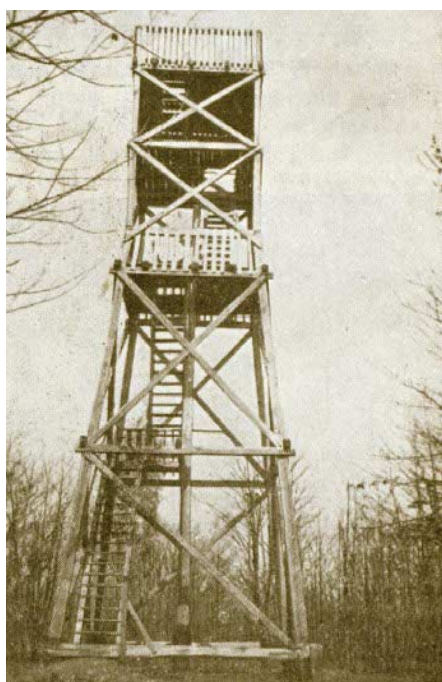
Vidikovac na vrhu Hrastovičke gore izgrađen je 1926., a na slici je stanje nakon 1938. kada je povišen na 16 m
