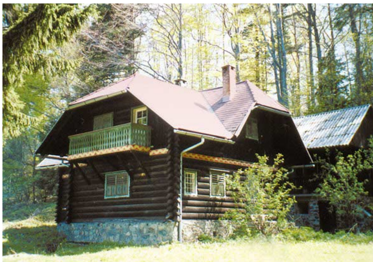
Lugarnica na Oštrici - obnovljena pa zapuštena
