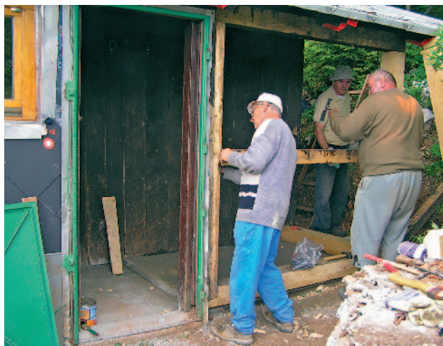
Postavljanje novih greda na drvarnici
