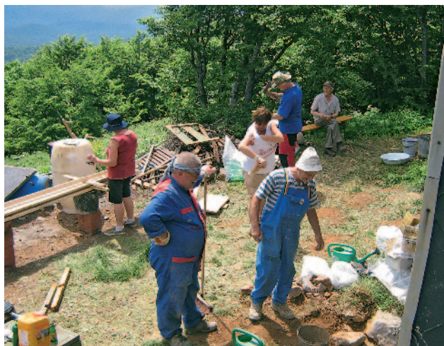
Pripremni radovi za postavljanje stuba prema podrumu
