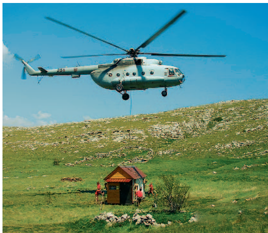
Postavljanje planinarskog skloništa »Rupe« na Dinari
