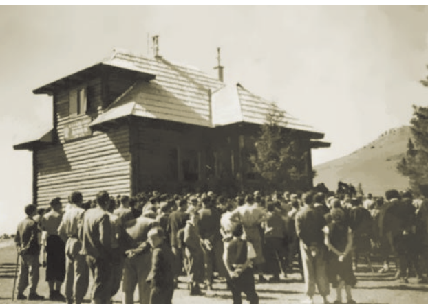
Otvorenje doma HPD-a »Bjelašnica« na Bukoviku
