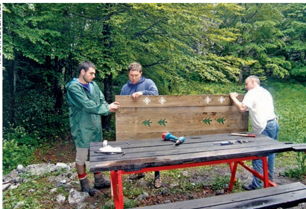
Obnova vrata poljskog zahoda uz planinarsku kuću
