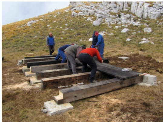
Postavljanje temelja za bivak u Ošljakovo stijeni
