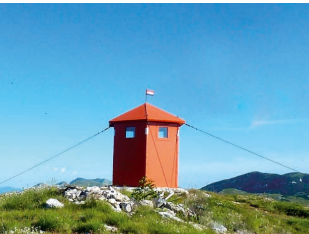
Sklonište na Jankovom brdu
