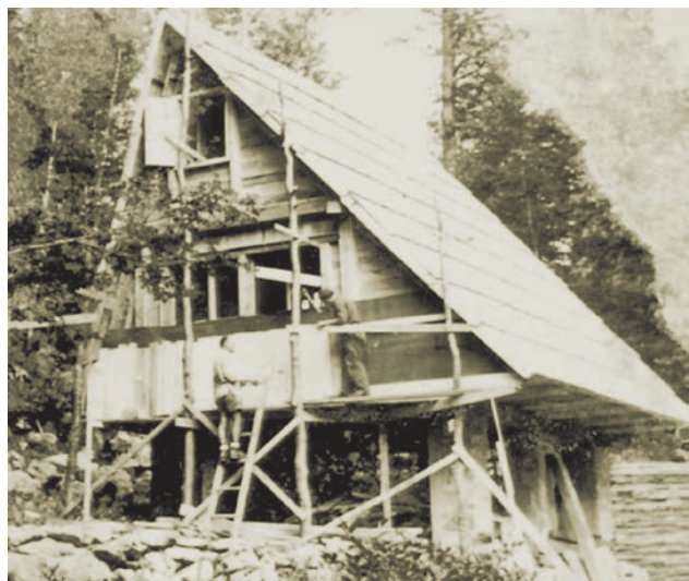
Izgradnja planinarske kuće na Bijelim stijenama 1968.
