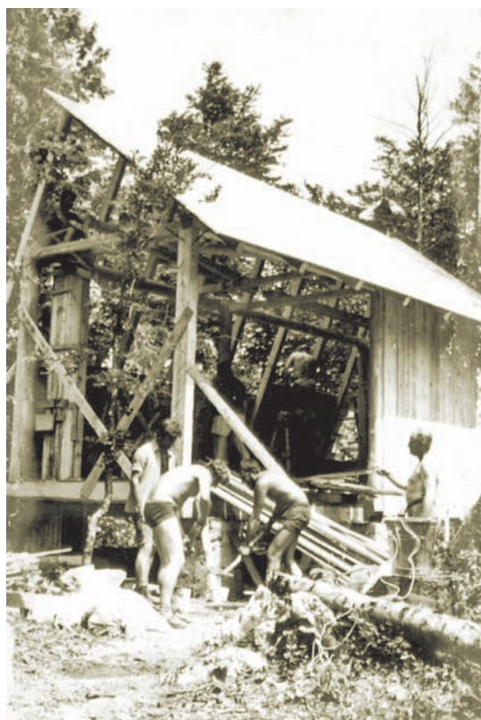
Izgradnja drugog skloništa
