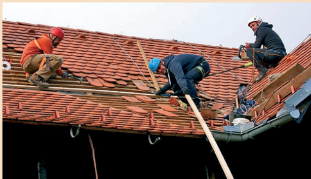
Hitna sanacija krovništva
