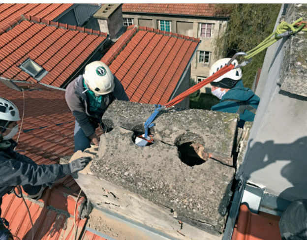
Pomoć kod uklanjanja oštećenih dimnjaka
