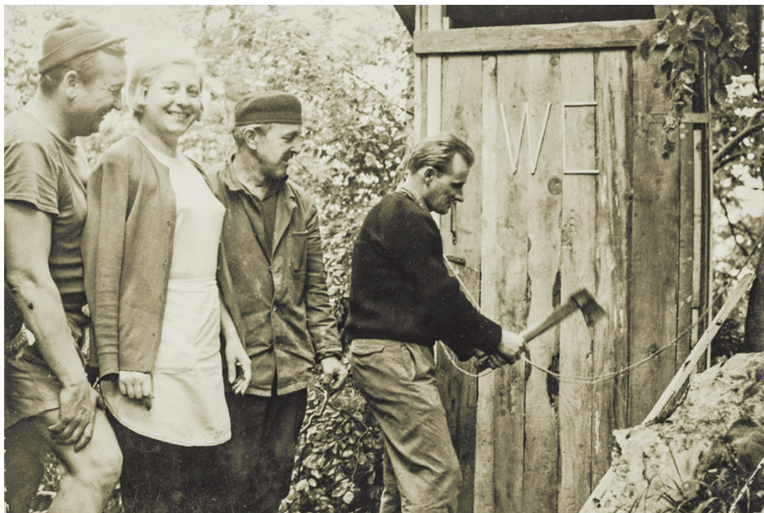
Svečano otvorenje važnoga objekta
