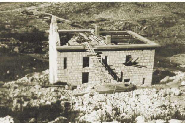
Dom u izgradnji
