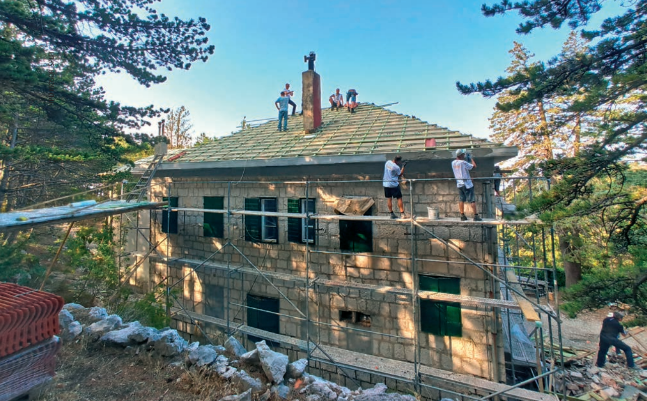
Radovi na krovu i pročelju
