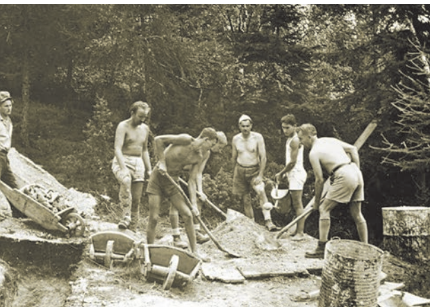
Betoniranje temelja na Vodicama - slijeva na desno Z. Bučar, Božo Skupnjak, Ljubo Cingerli, Ivo Ott, Neno Pauković, Štefan Vuković
