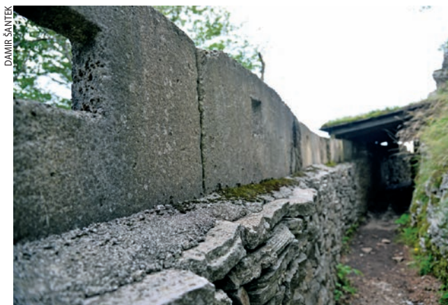
Ostaci bunkera iz Prvog svjetskog rata
