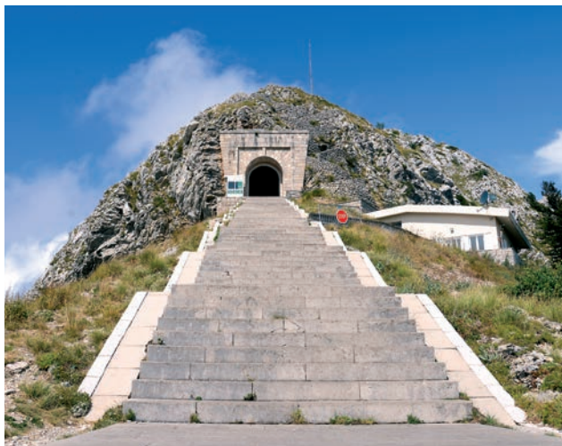
Pješačko stubište i tunel za prilaz Njegoševu mauzoleju
